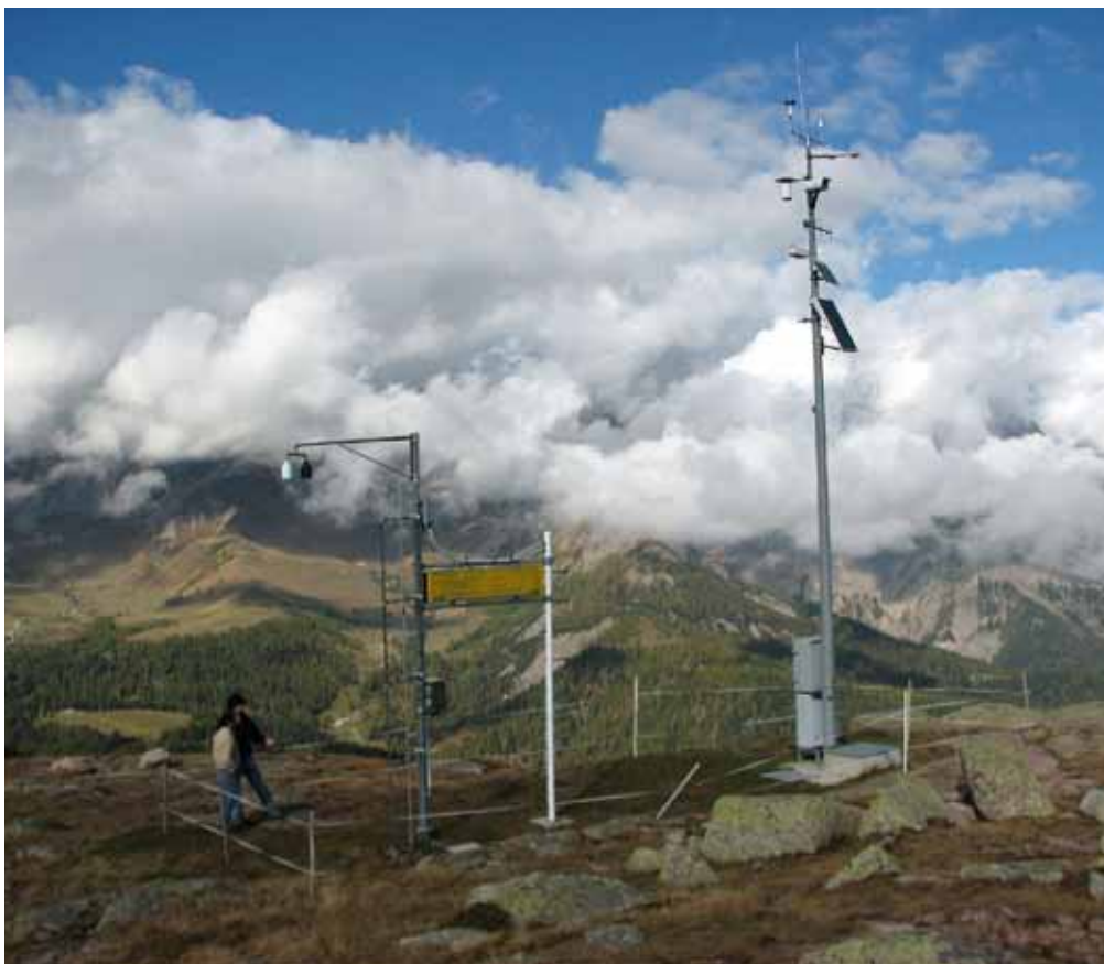
Fig. 1 - Stazione di monitoraggio di Cima Pradazzo. Sul palo principale sono fissate le webcam.
